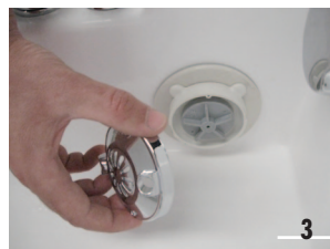
Bild 7 Reinigung des Laufrades des Whirlpools
