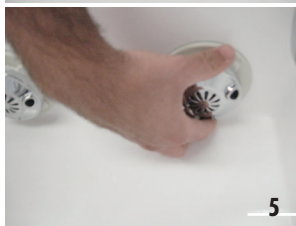
Bild 7 Reinigung des Laufrades des Whirlpools
